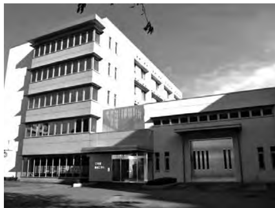
機械工学科棟 津田沼キャンパス12号館
