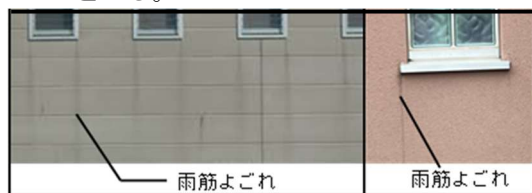
写真 1 雨筋よごれの事例
