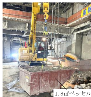
a. コンクリートガラ質量測定
