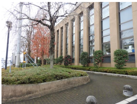
写真5 整備前の市役所前(2019年 本研究室撮影)
