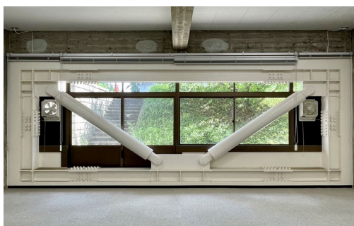
図 1 鉄骨鋼管ブレース外観
