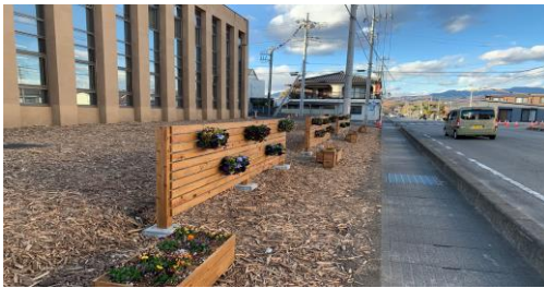
写真2 整備後の安中市役所前
