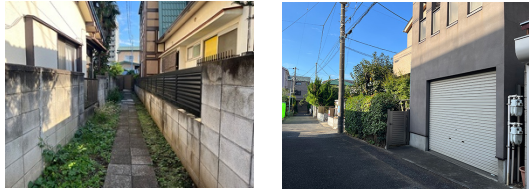
Fig.4 閉鎖的な空間
