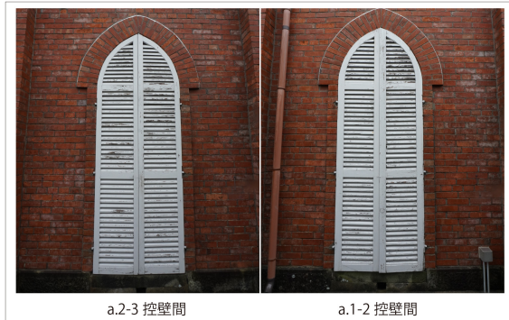
Fig.4 堂崎教会控壁間の煉瓦積み
