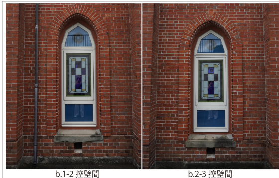
Fig.7 楠原教会控壁間の煉瓦積み
