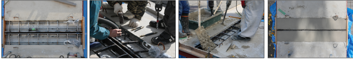
1) 伸縮装置設置
