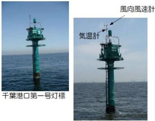
図3 千葉灯標観測機の設置風景
