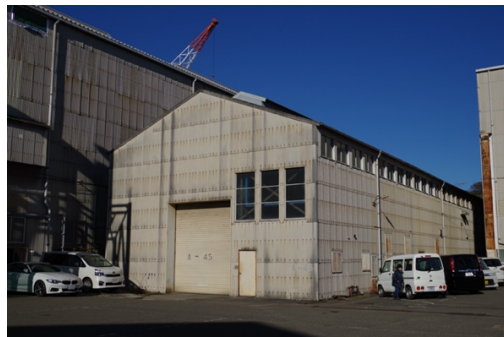
写真1 旧横須賀海軍工廠造機部の仕上場
