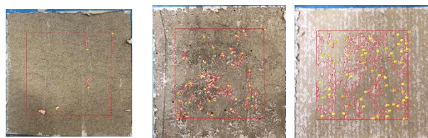
フレキシブルボード (剥離率: 98%) コンクリート板 (剥離率: 86%) ケイカル板 (剥離率: 68%)
