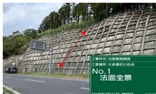
図-1 研究対象地の道路法面
