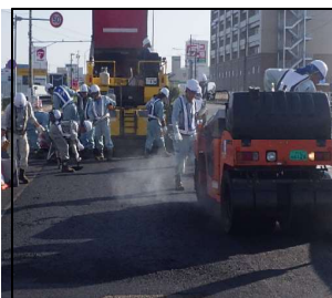
(8) 橋面防水工・アス ファルト舗装
