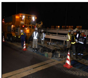
(5) モービル車による コンクリート練混ぜ
