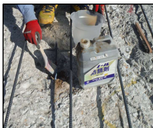
(1) 鉄筋の発錆箇所の補修
