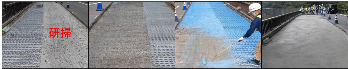
(1) 展張格子筋設置・研掃 (2) 浸透性接着剤塗布 (3) 付着用接着剤塗布 (4) SFRC打ち込み・表面仕上げ
