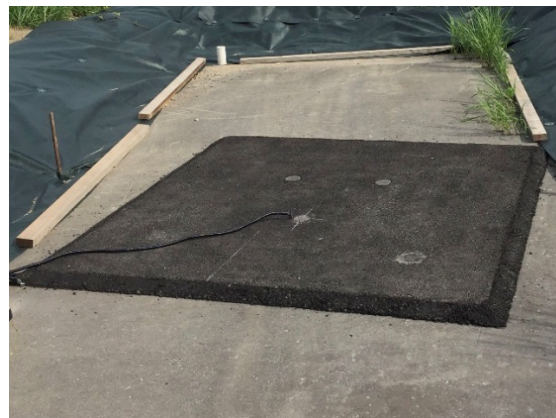
写真-1 新設の舗装の外観
