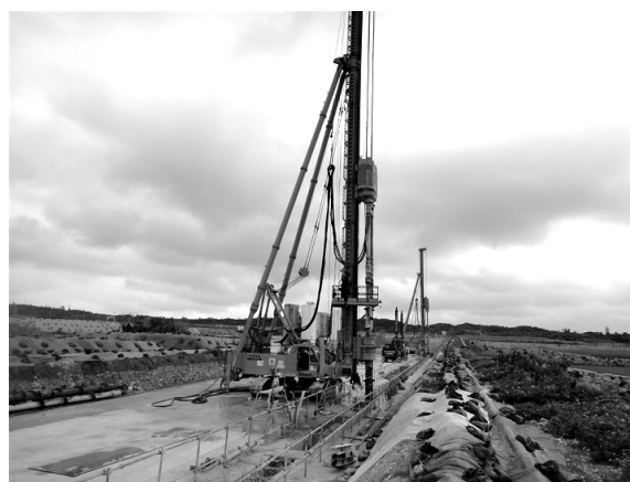
写真2 SMW工法による遮水壁施工
