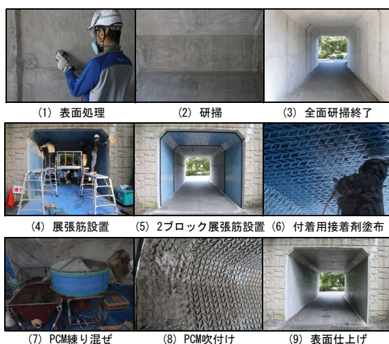
写真-2 カルバートの施工事例
