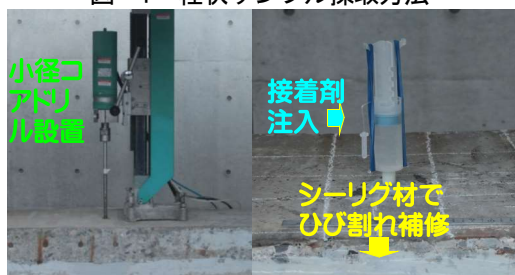
(1) ドリルの設置 (2) 接着剤の注入状況 写真-3 ドリルの設置と接着剤の注入状況
