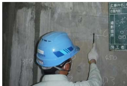
写真2 実際に打込みをしたPCMでの測定状況
