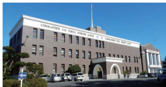
写真1 旧横須賀鎮守府庁舎
