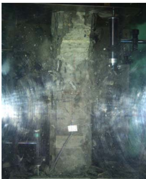
図6 柱の爆裂状況 (動画の1コマ)
