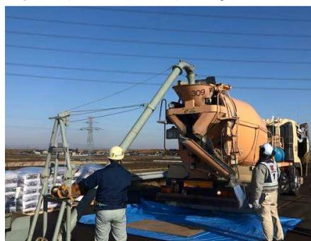
写真-2 アジテータ車への鋼繊維の投入
