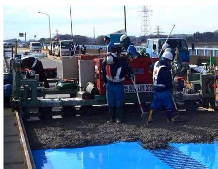
写真-3 SFRCの専用機械による締固め
