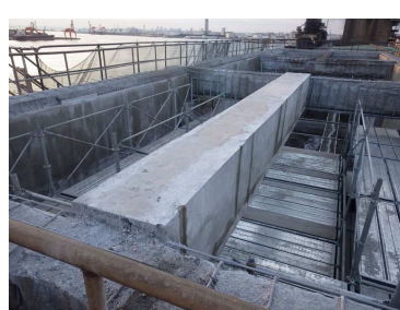
写真-6 完成状況
