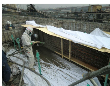
写真-5 吹付け状況
