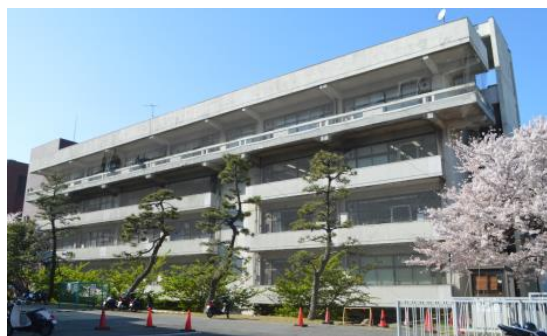
写真 1 4 号館南側写真
