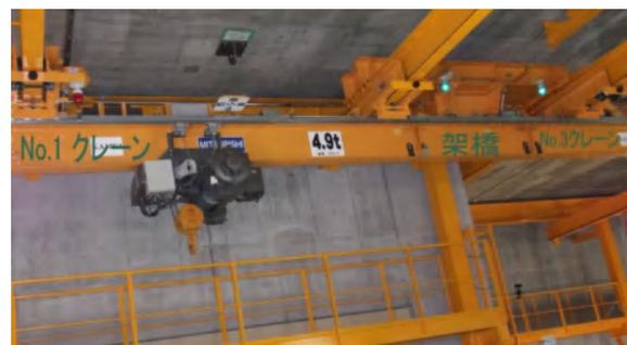
図3 架橋付クレーン、左から順に No.1 クレーン、ホイスト、架橋、そして No.2 クレーンと並ぶ
