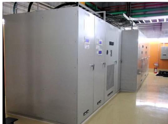
図5 K4室に設置された、金属閉鎖型高圧配電盤(Metal Clad Switchgear)
