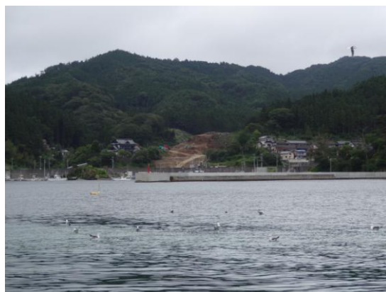
写真2. 人工地盤工事の様子
