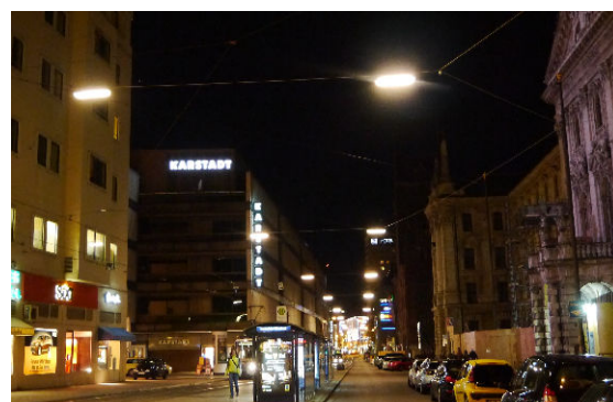
図7 カテナリー照明方式 (ドイツ・ミュンヘン)
