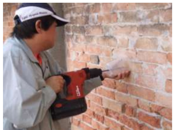
写真-9 ドリル削孔状況
