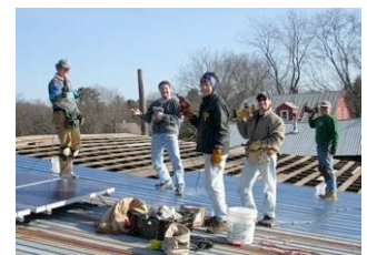
ソーラーパネル設置作業
