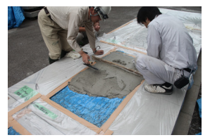
写真-6 補修材打込み
