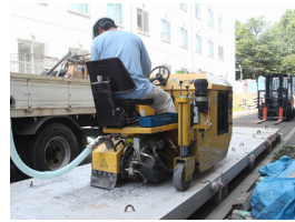
写真-1 切削状況
