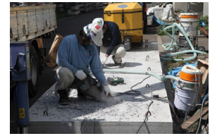
写真-2 ハツリ状況
