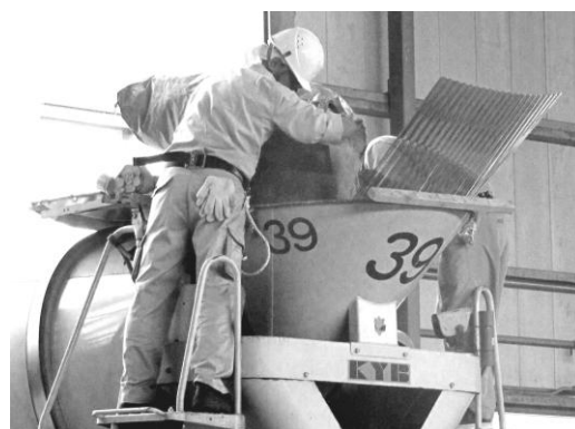
写真-2 ビニロン繊維添加の様子
