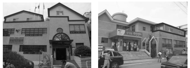
図6 ペイントハウス増築事例外観写真
