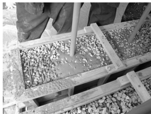
写真-3 梁試験体の打設状況
