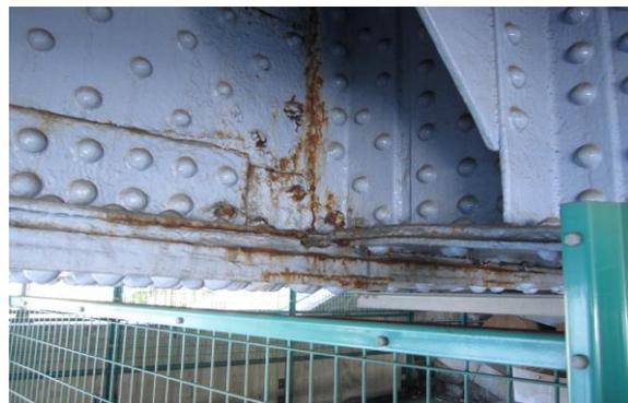
写真-1 縦桁添接部
