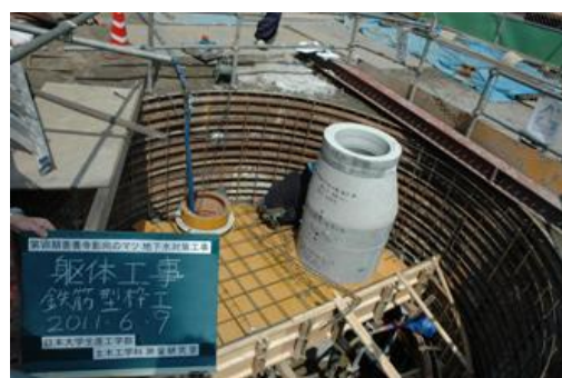
写真3 躯体工事の施工監理
