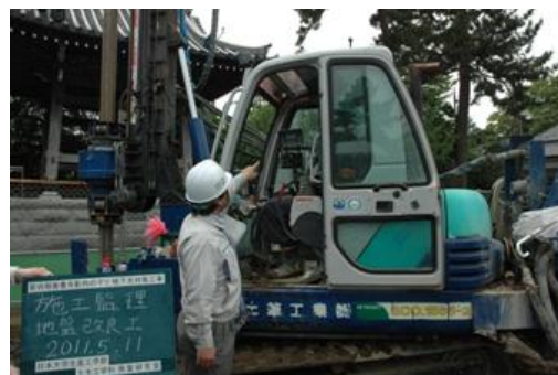
写真1 地盤改良工事の施工監理
