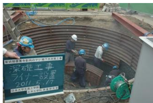
写真2 深礎工事の施工監理
