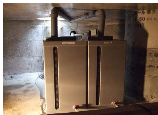
写真4 設備工事の施工監理
