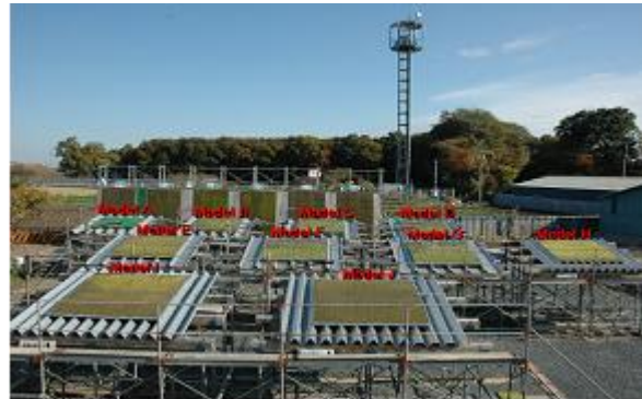
写真 - 1 現場風景
