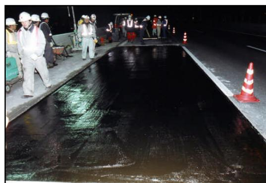
写真-2 アスファルト系橋面防水施工状況
