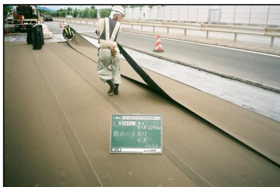
写真-1 シート系橋面防水施工状況
