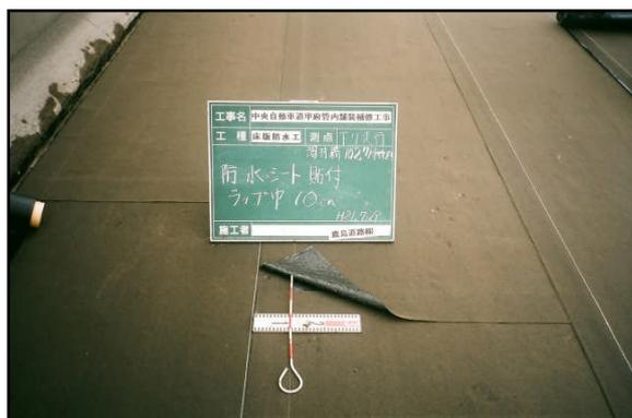
写真-4 シート系の重ね合わせ状況
