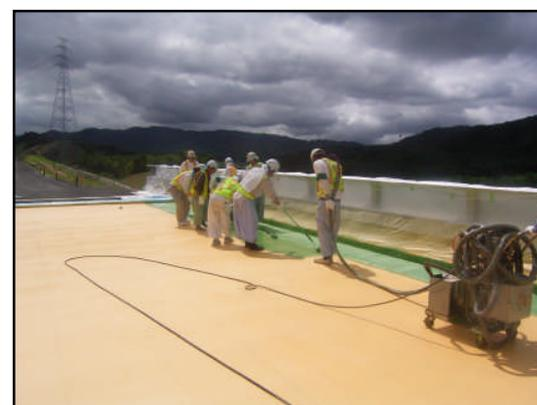
写真-3 ウレタン樹脂系橋面防水施工状況
