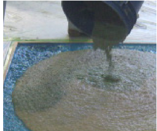
【モルタル打ち込み】
