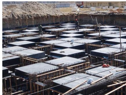
図3 断面積約830m<sup>2</sup>の水チェレンコフ検出器用水槽のクラスターの建設状況(10月撮影)。本年度中に4個竣工予定。コンクリートの上で2.5mの土を盛り固める。
