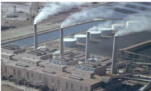
写真1 例えば火力発電所の煙突内
