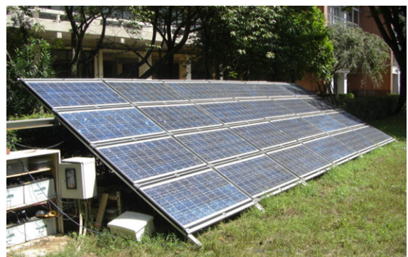
写真1 太陽光発電システム設置風景
