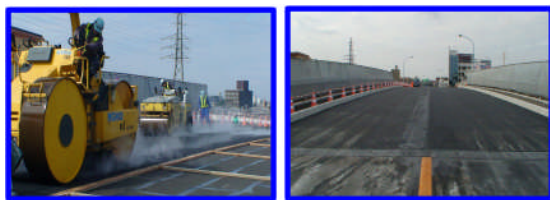
写真 19 アスファルト表層工(転圧) 写真 20 完了
