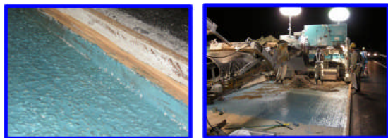
写真 21 接着剤(端部塗布) 写真 22 SFRC 打込
