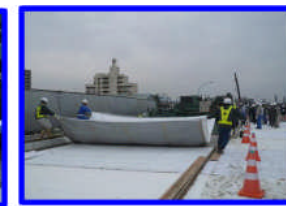
写真18 養生マット設置
