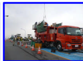
写真12 SFRC 製造
