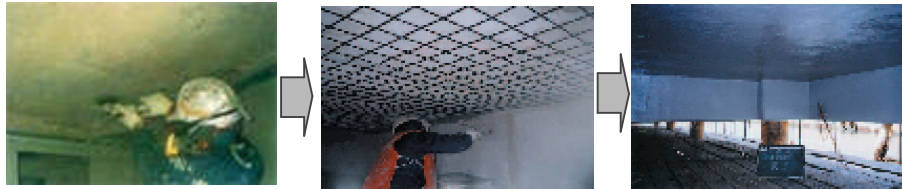
(1)下地のケレン清掃 (2)格子筋のアンカー設置 (3)モルタル吹き付けによる補修完了
