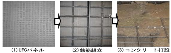
図-3 実験供試体の施工方法
