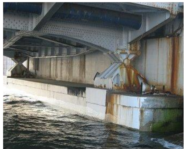
写真 5 勝関橋の沓周りの状況 (2009 年 10 月 9 日撮影)
