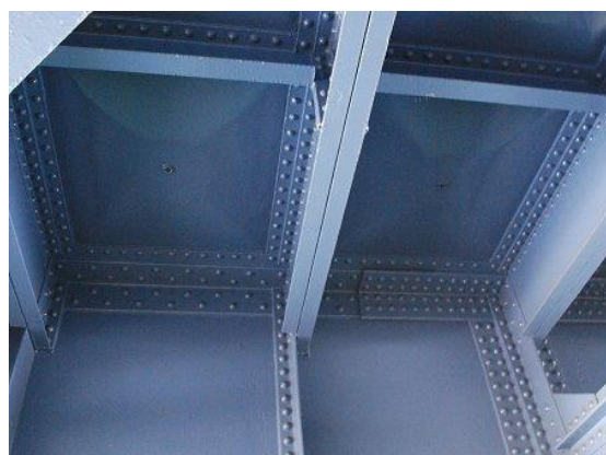
写真 3 清洲橋のバックルプレート (2009 年 7 月 21 日撮影)
