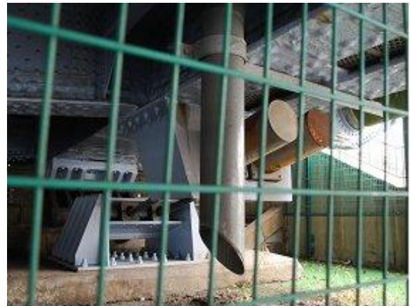
写真 4 永代橋の落橋防止装置 (2009 年 10 月 9 日撮影)
