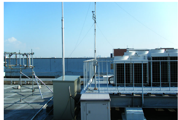
図2 観測用アンテナ（無指向性）
