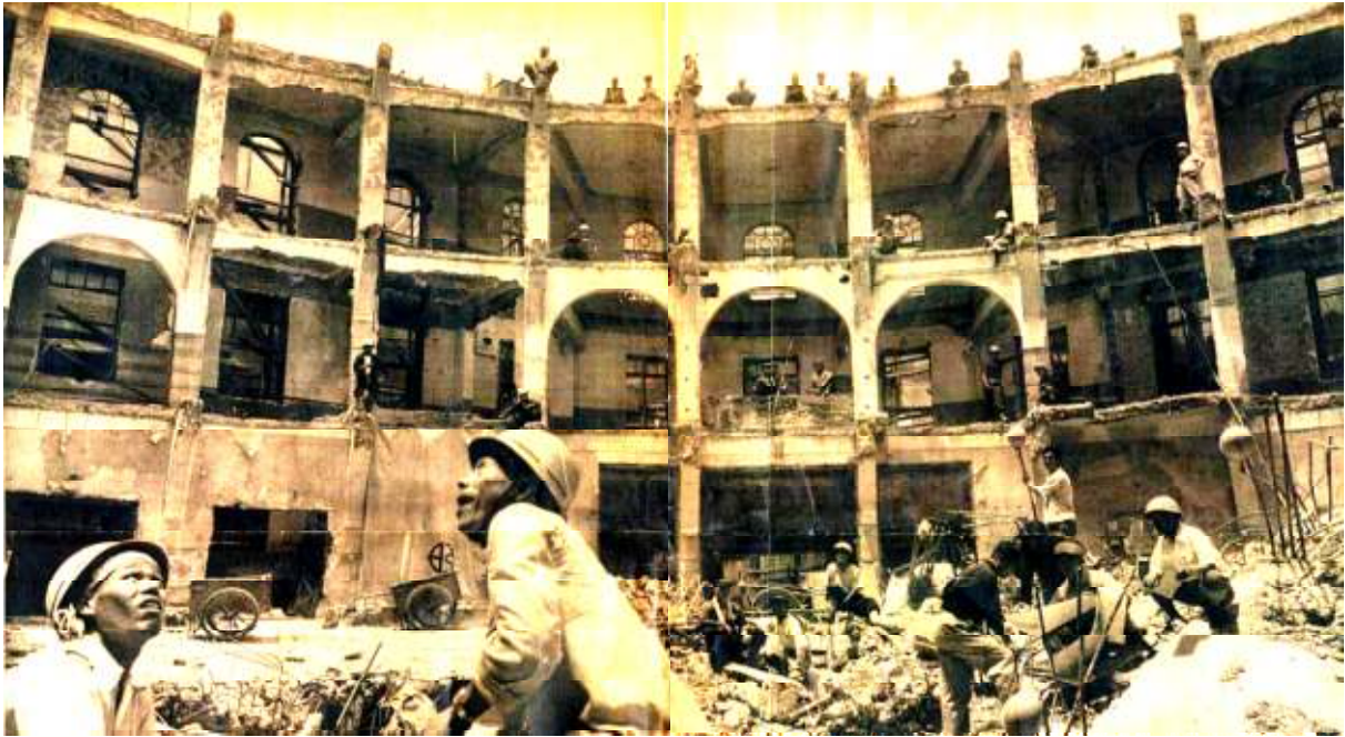
図5 戦後のRC解体の様子 (出展：アサヒグラフィア)
