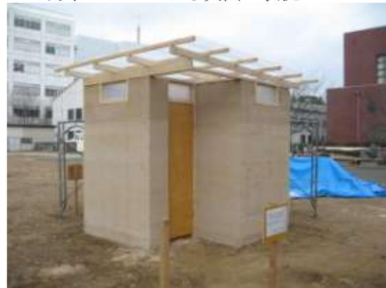
写真3 版築工法による小屋
