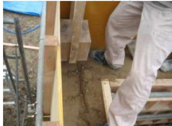
写真2 タコによる突固め状況
