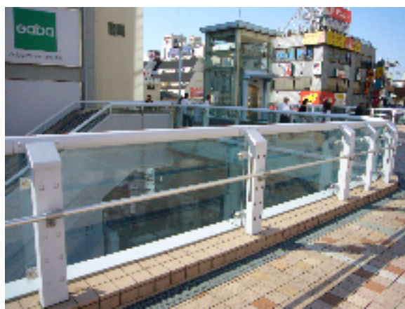
写真-4 北千住駅西口ペDESTリアンデッキのガラスを使用した高欄(平成 21 年 9 月撮影)
