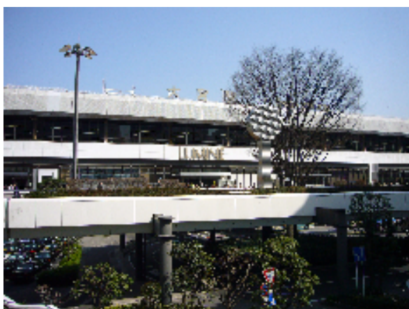
写真-1 大宮駅西口ペDESTリアンデッキのハイポール照明 (平成 21 年 3 月撮影)
